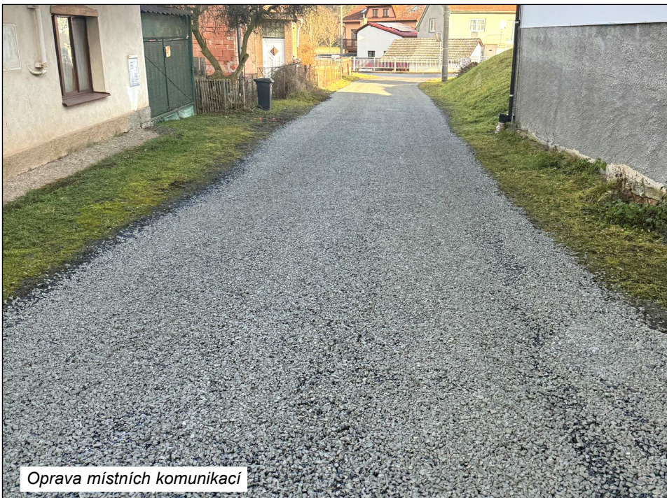
Oprava místních komunikací
