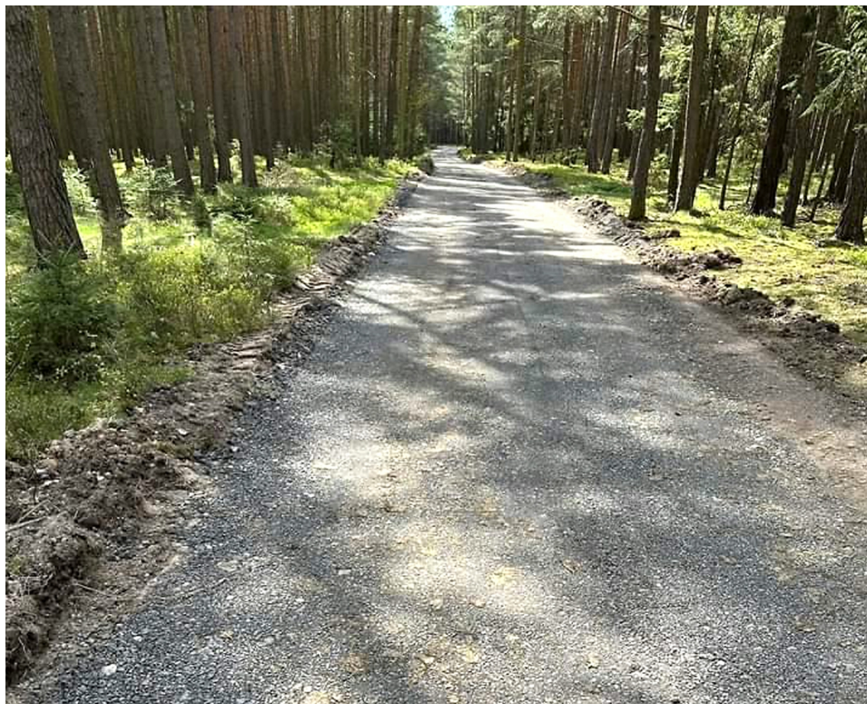
Úprava místních účelových komunikací
